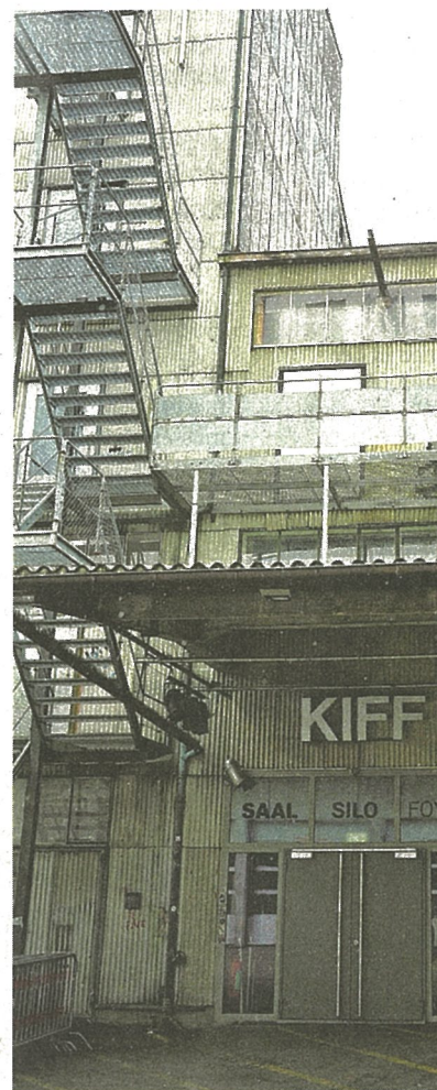
Offene Türen beim KIFF in Aarau.
